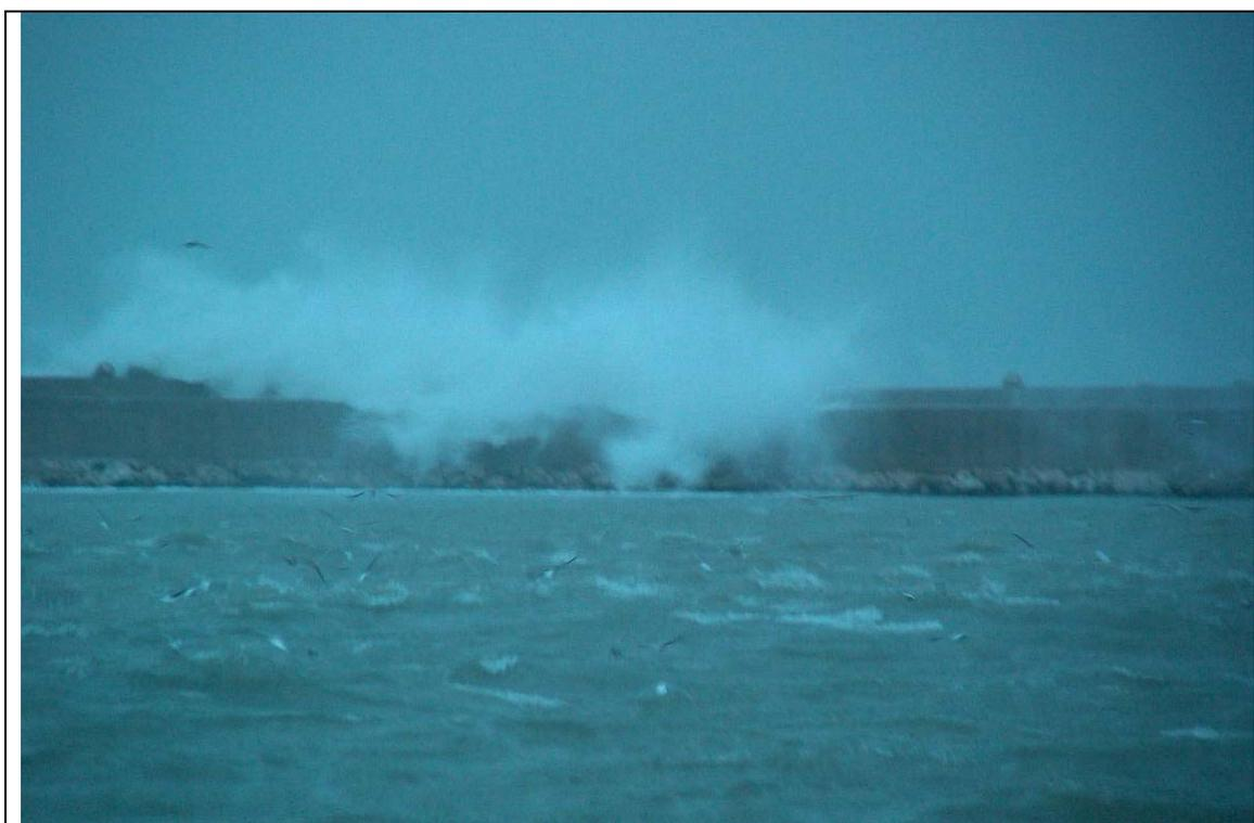
**Figura 34: Mareggiata del 23 Dicembre 2003 con tracimazione della diga foranea del porto di Pescara. Fotografia scattata alle ore 07:42 locali.**
